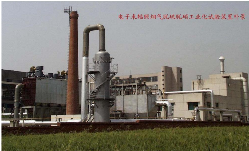
Пилотная установка по очистке SO 2 and NO x производительностью до 12000 н.м 3 /ч дымовых газов мощностью электронного ускорителя ~ 36 кВт. 1999 год.
